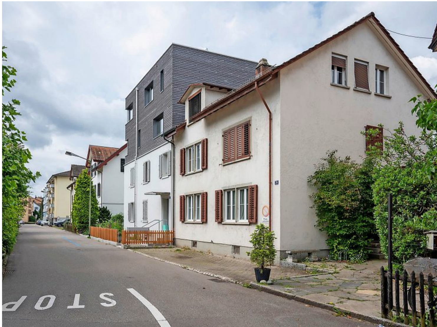
Nach diesem Beispiel sollte am Ende der Bleichstrasse in Veltheim ein weiteres Haus aufgestockt werden. Das Projekt verfolgen die Architekten nun vorerst nicht weiter. Foto: Michael Trost
